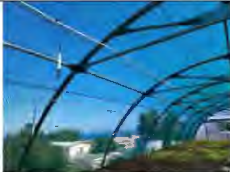
Ancien système d'irrigation avec 5 rampes d'arrosage et les aspersion espacés de plus de 2 mètres
