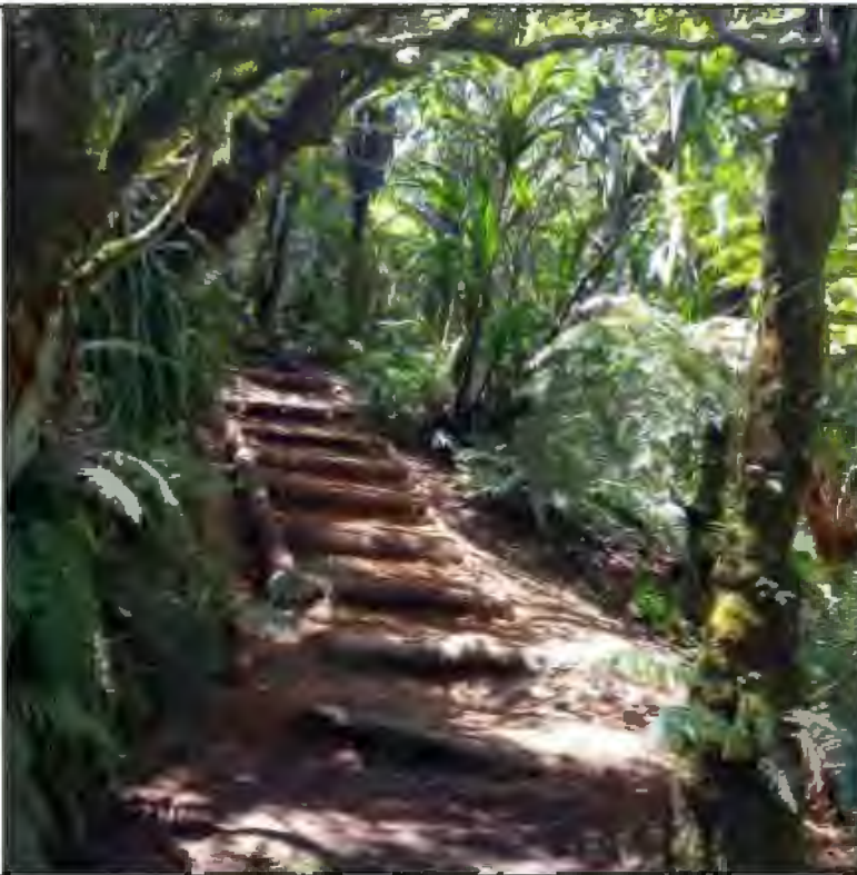
Photo : rénovation des marches sur la forêt de Notre Dame de La Paix
