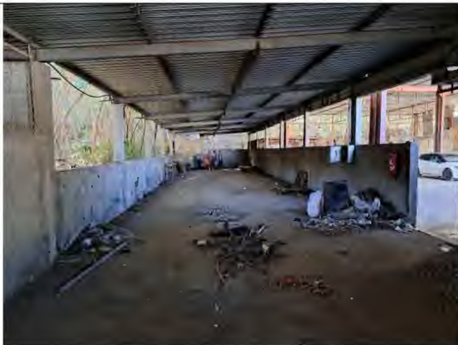
Pépinière Bois de fer : hangar avant nettoyage (Ex-REDETAR)
