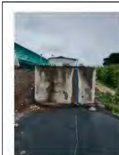
Pépinière Bois de fer Ancienne citerne en béton
