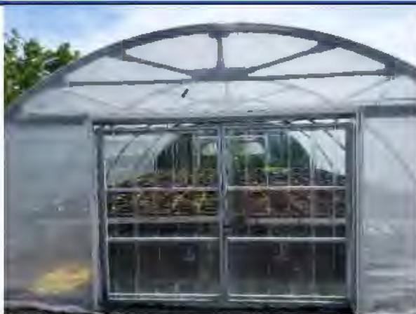
Pépinière Bois de nêfles : serre bi-tunnel
