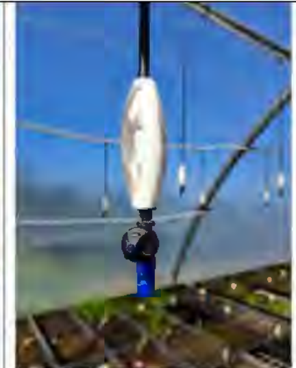
Brumiseurs avec clapet anti-vidange, système anti-gouttage et buse « Green mist »
