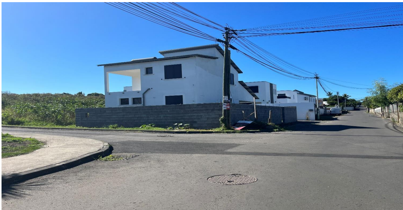
Vue du chemin Cannes Purisies et du lotissement voisin de l'opération
