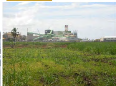
L'USINE DU GOL
